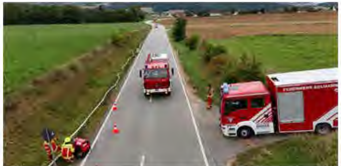
Im Rahmen einer Großübung in Hauzenstein wurde von Thanhausen eine 2300m lange B Leitung verlegt.
