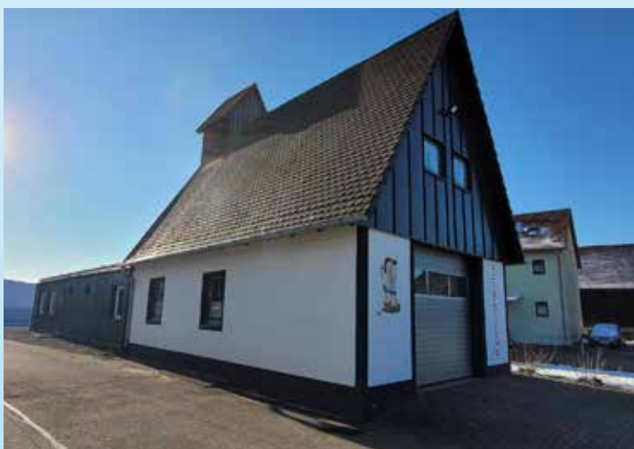
Gerätehaus FF Riekofen
