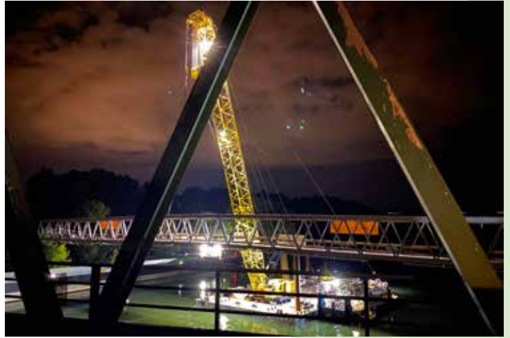
Sicherheitswache beim Einhub der Geh- und Radwegbrücke in Kleinprüfening
