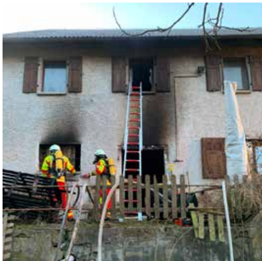
Rauchentwicklung im Gebäude in Urtlhof
