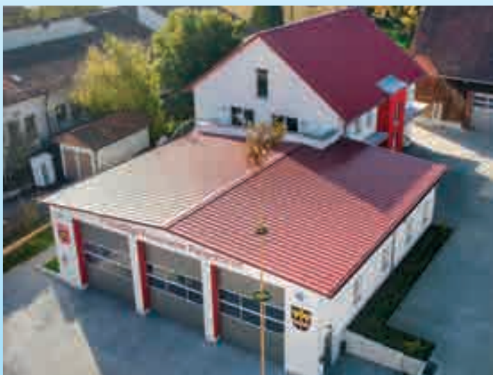
Neubau Gerätehaus FF Pielenhofen
