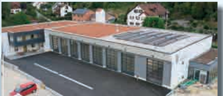
Neubau Gerätehaus FF Beratzhausen
