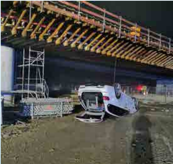
VU mit PKW B16 Baustelle Wenzelbach
