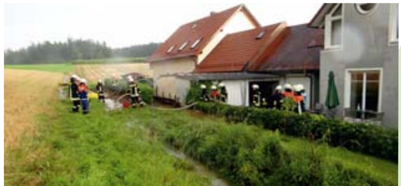
Ein schweres Unwetter verwüstete große Teile des westlichen Landkreises. Besonders betroffen war am 26. Juli die Ortschaft Undorf. Alle Feuerwehren des Marktes Nittendorf waren im Einsatz.
