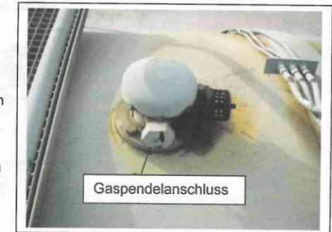
Abb. 23 Sicherheitsventil mit Gaspendelanschluss (Fa. Kito)
